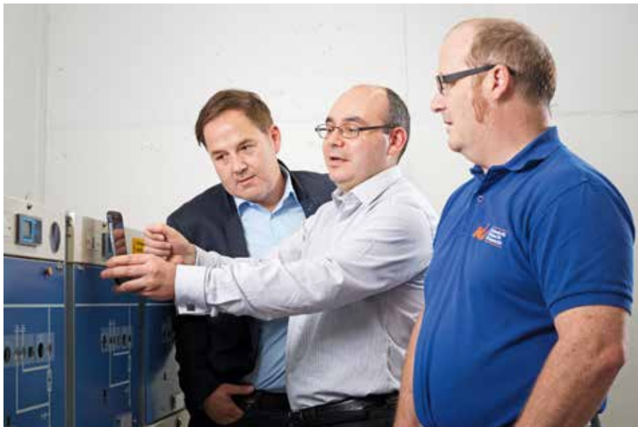
Ortsbegehung: Felix Tresch, Geschäftsführer IDS Schweiz AG, Informatiker René Meier und Andy Kreuzer, Geschäftsführer IDS Gruppe Schweiz AG, in der Trafostation Luzern Allmend (von links).
