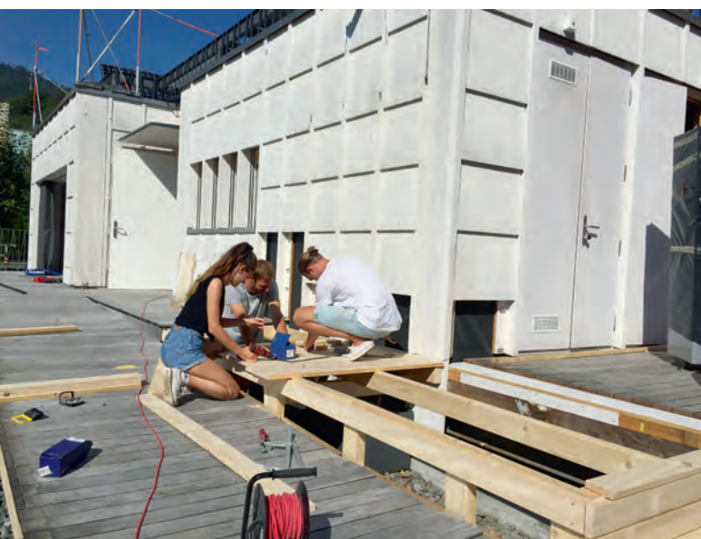
Umbau des Solar Decathlon-Hauses vom TraktX zum Elefant.
