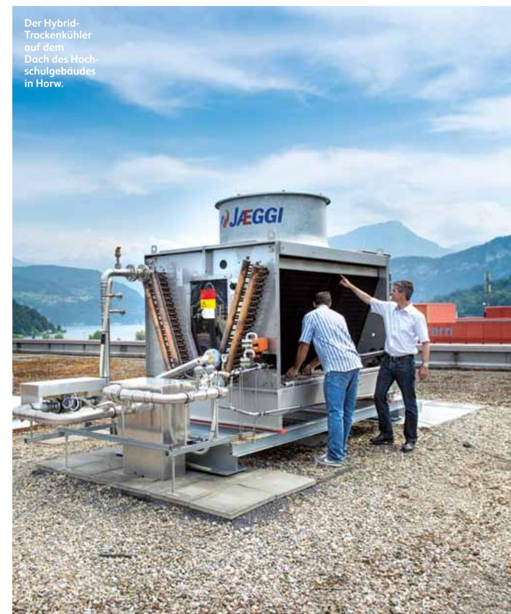
Der Hybrid-Trockenkühler auf dem Dach des Hochschulgebäudes in Horw.
