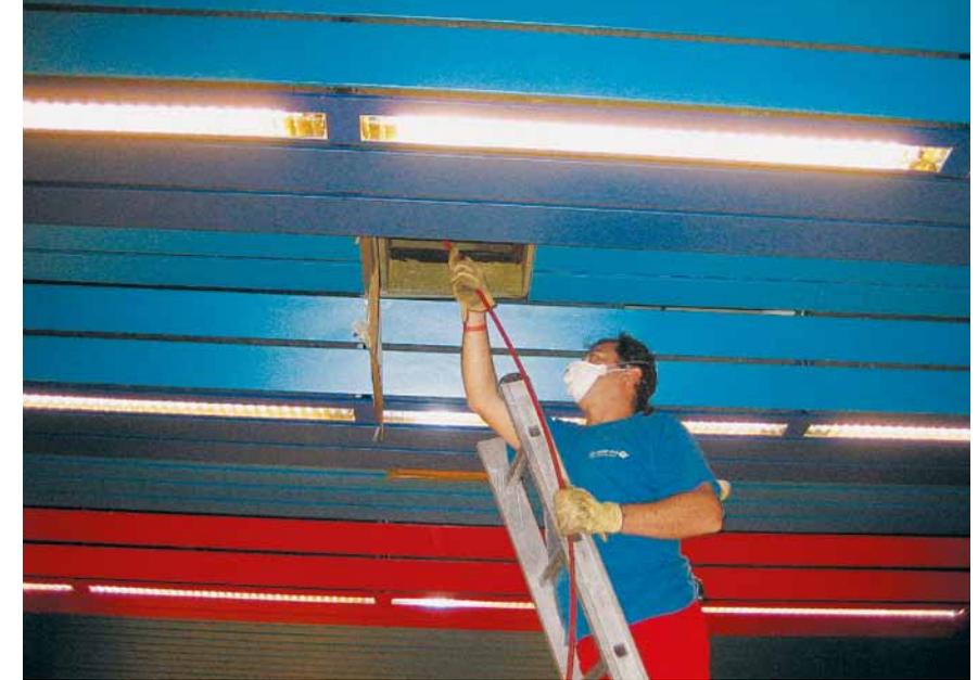
Experten untersuchten 100 raumlufttechnische Anlagen: Sie prüften u.a. die Zugänglichkeit, die korrekte Montage und den hygienischen Zustand.
