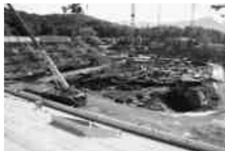
Die swissporarena im Bau
