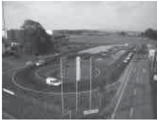
Fahrpiste TCS Prüfzentrum Emmen
